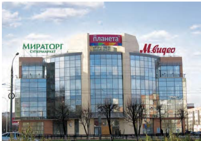
ТОРГОВЫЙ ЦЕНТР «ПЛАНЕТА» Йошкар-Ола, 836 квТ
