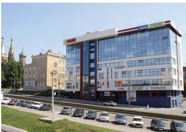
БИЗНЕС-ЦЕНТР «НАЙДИ» Ижевск, 498 кВт
