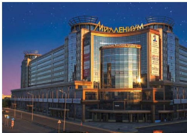
ТОРГОВЫЙ ЦЕНТР «МИЛЛЕНИУМ» Омск, 410 кВт
