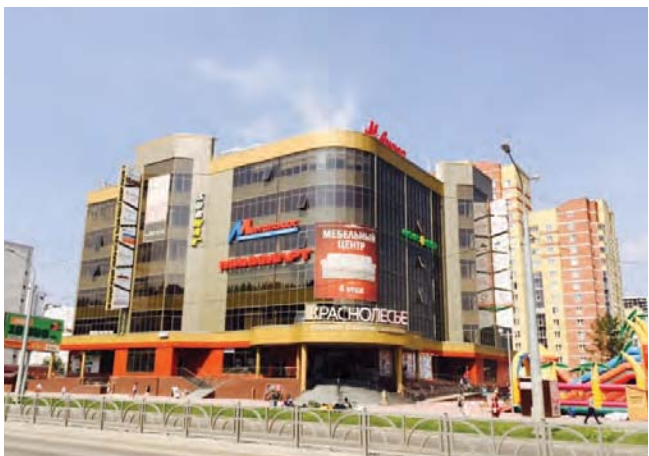
ТОРГОВЫЙ ЦЕНТР «КРАСНОЛЕСЬЕ» Екатеринбург, 700 квТ
