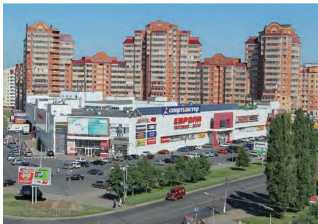
ТОРГОВЫЙ ЦЕНТР «ЕВРОПА 26» Железногорск, 320 квТ
