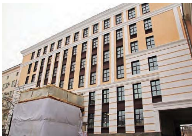
БИЗНЕС-ЦЕНТР «БАСМАНЫЙ ПАРК» Москва, 495 кВт
