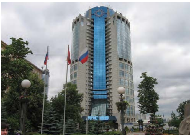
ГУП «МОСВОДОСТОК» Москва, 440 кВт
