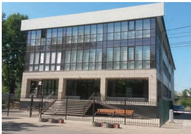
КОЛЛ-ЦЕНТР «ТЕЛЕ2» Иркутск, 300 квТ
