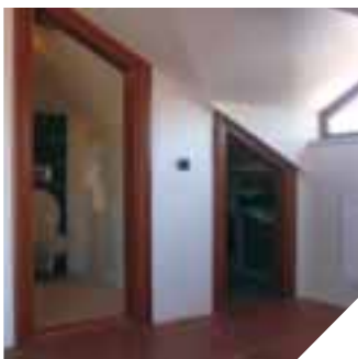
Мансардное помещение, в котором необходимо оборудовать душевую комнату
