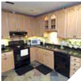
Кухня цокольного этажа: слив раковины и посудомоечной машины подсоединен к насосу Sanitive компании SFA
