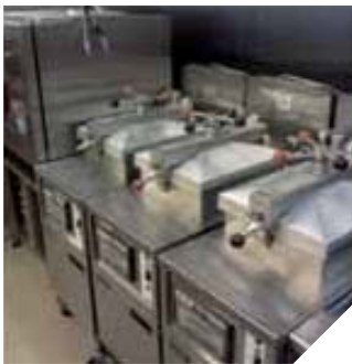
Кухонные плиты, стоящие на отдалении от канализационной трубы
