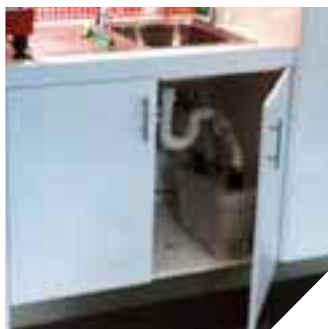
Sanispeed, вмонтированный в шкаф раковины
