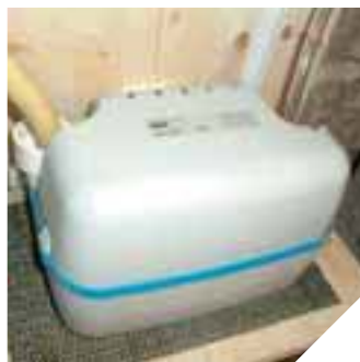
Sanicondens, соединенный с осушителем
