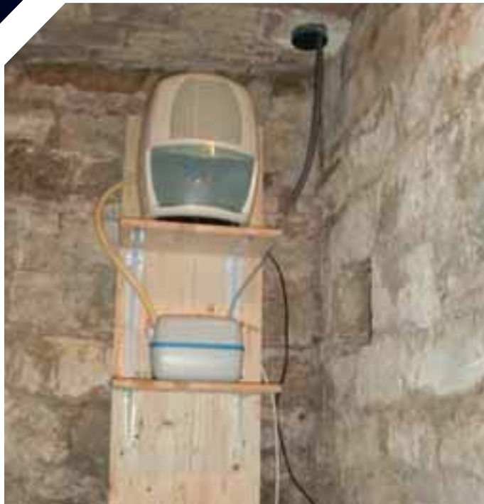
Установленный в подвале осушитель
