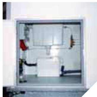
Система SFA, установленная под входными дверями
