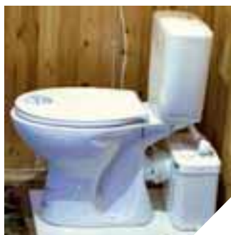
Унитаз, установленный в бане, с насосом Sanibroyeur
