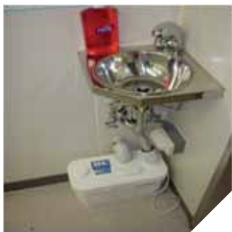
Sanivite, установленный в комнате 1
