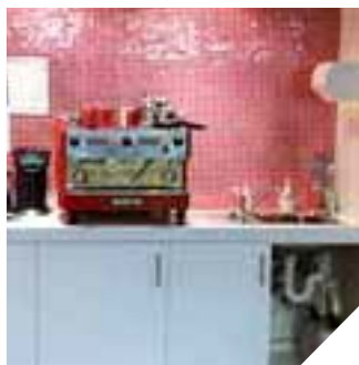
Слив раковины происходит в Sanispeed
