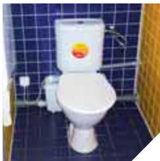
Установка Sanibest на один унитаз для взрослого
