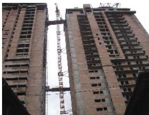
Идет строительство. Жилые здания высотой более 20 этажей. Установлено 520 фитингов Sovent.
