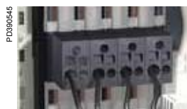
Ответительные клеммы для кабелей сечением 6 и 10 мм 2
