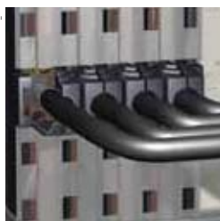
Защелкивающиеся крышки для изоляции наконечников комплекта для подсоединения
