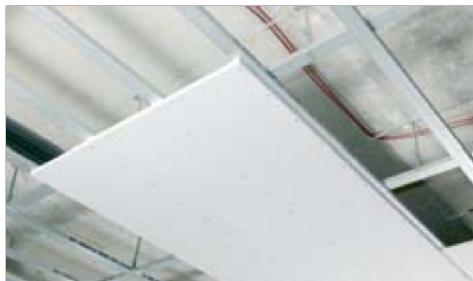
Рис. 3-05 Смонтированный потолочный элемент
