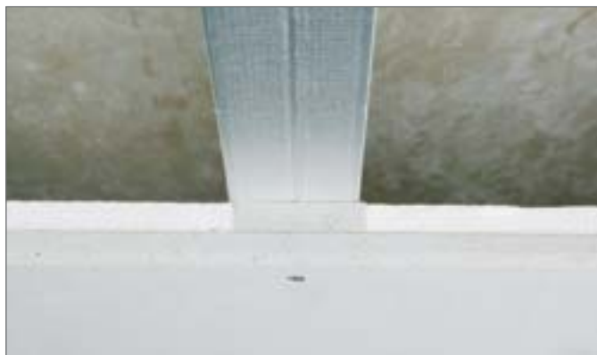
Рис. 3-06 Крепление потолочных панелей
