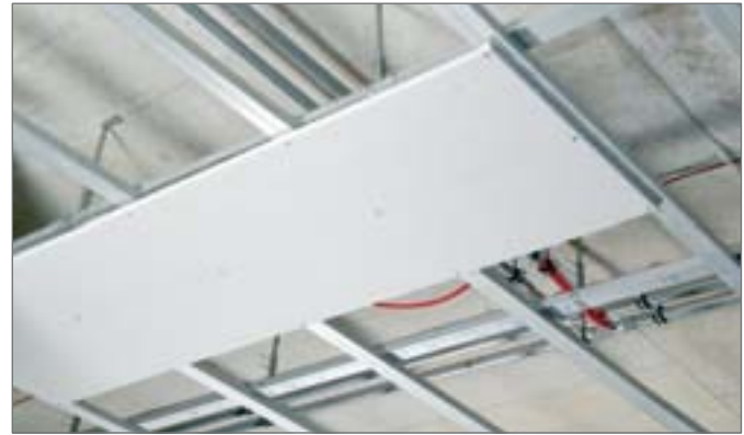
Рис. 4-05 Стеновая панель обогрева/охлаждения, смонтированная на потолке
