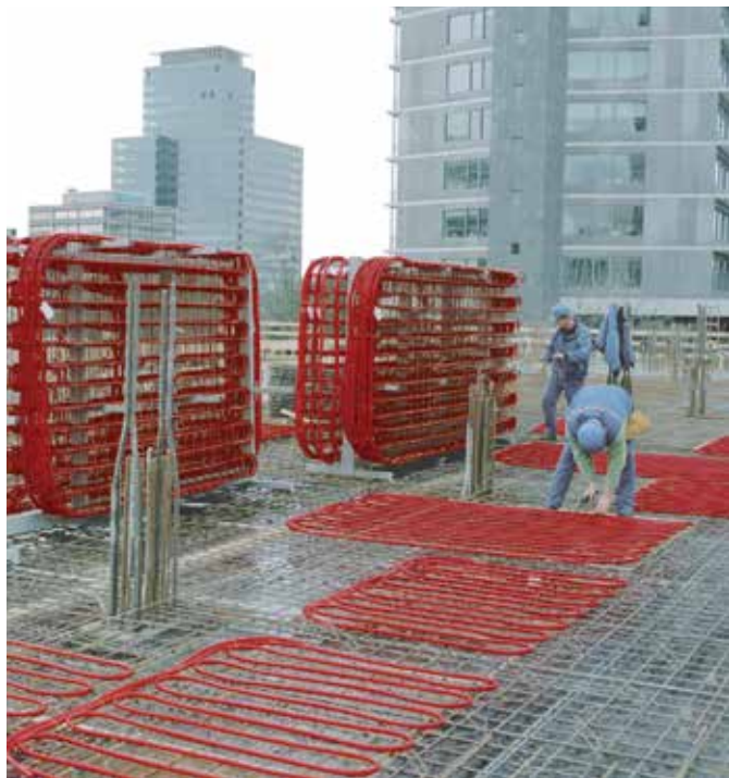
Подогрев и охлаждение ядра бетонных перекрытий
