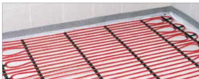
Система напольного отопления/охлаждения («мокрый» способ укладки труб)
