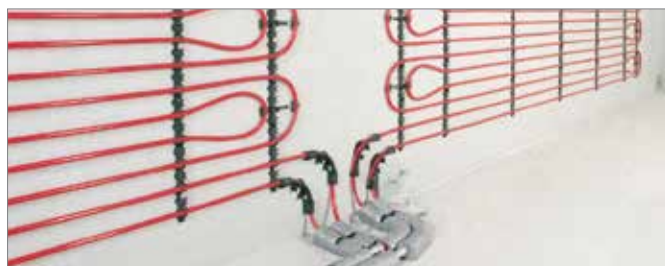
Система настенного отопления/охлаждения («мокрый» способ укладки труб)
