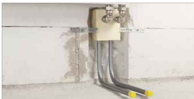
Присоединительный блок RAUTITAN для подключения отопительного прибора
