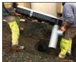
Установка песколовки
