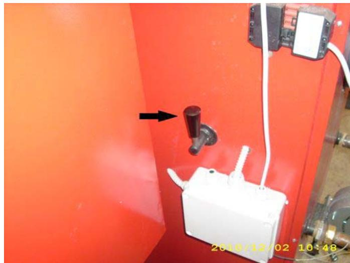
Рисунок 9. Положение ручки клапана «ПОДЖИГ»
