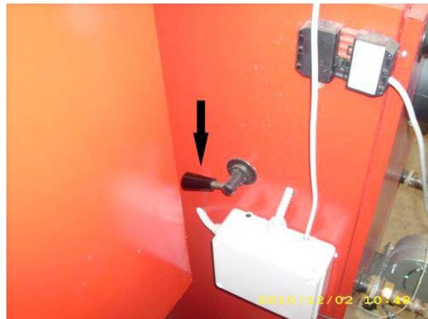
Рисунок 7. Положение ручки клапана «РАБОТА»
