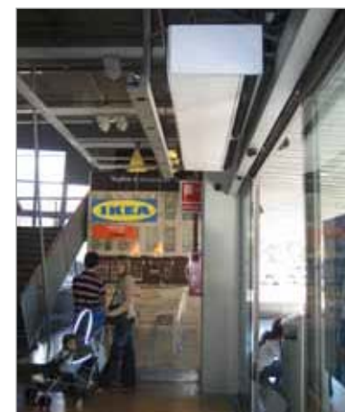
Windbox Разработана для установки в потолке
