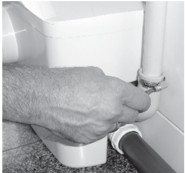
(Abb. 4) Zum Anschluß der Druckleitung befestigen Sie die DN 25-Druckleitung im Abgangsbogen, der sich oben rechts am Behälter befindet, mit einer Schelle. Verlegen Sie die Druckleitung stetig steigend (im Idealfall erst senkrecht, dann waagerecht) in einer Schleife über das Niveau der Rückstauenebene des öffentlichen Abwasserkanals. Dies verhindert, dass bei einem Ansteigen des Wasserspiegels im Abwasserkanal, z. B. bei starkem Regen, Abwasser durch die Druckleitung in den Behälter der Saniflux zurückgedrückt wird. Führen sie die Druckleitung von dort direkt bis zum nächsten Sammelabfluss. Überprüfen Sie nochmals alle Anschlüsse und Verbindungen auf ihre Dichtigkeit. Stecken Sie nun den Stecker in eine geerdete Steckdose, die Hebeanlage ist jetzt betriebsbereit.
