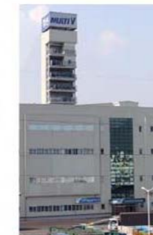
Проверка работы системы при удалении блоков системы друг от друга по вертикали
