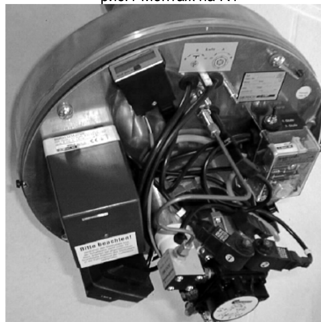
рис.2 Монтаж на R20
