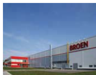
Производственный комплекс BROEN в Коломне
