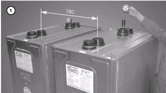
Установите резервуары рядом друг с другом: DWT – на ножки, а KWT – на пол; минимальное расстояние между центрами резервуаров примерно 780 мм {DWT}, соответственно 840 мм {KWT}, используются проставочные диски). Ввинтите часы с указателем уровня заполнения в резьбовую втулку на третьем штуцере резервуара (DWT)
