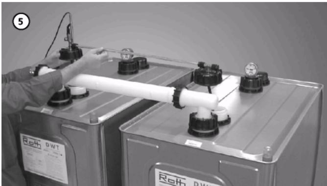
Установите трубопровод для отбора на второй штуцер резервуара. При этом смонтируйте арматуру для сбора вместе с датчиком предельных значений на первом резервуаре в направлении заливки. Настройте датчик предельных значений в соответствии с таблицей.
