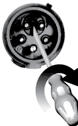
Рис. 30 Смена фаз трёхфазного шкафа управления с фазовым инвертером
