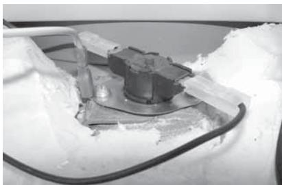
Рис. 26: Кнопка включения предохранительного термостата
