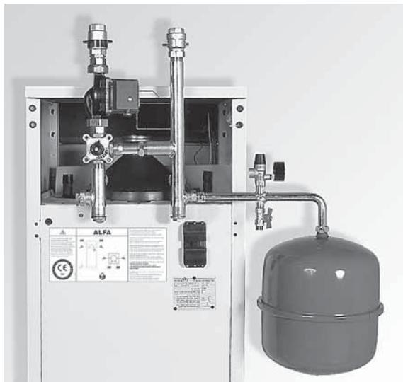
Рис. 4: Собранный гидравлический комплект ACV
