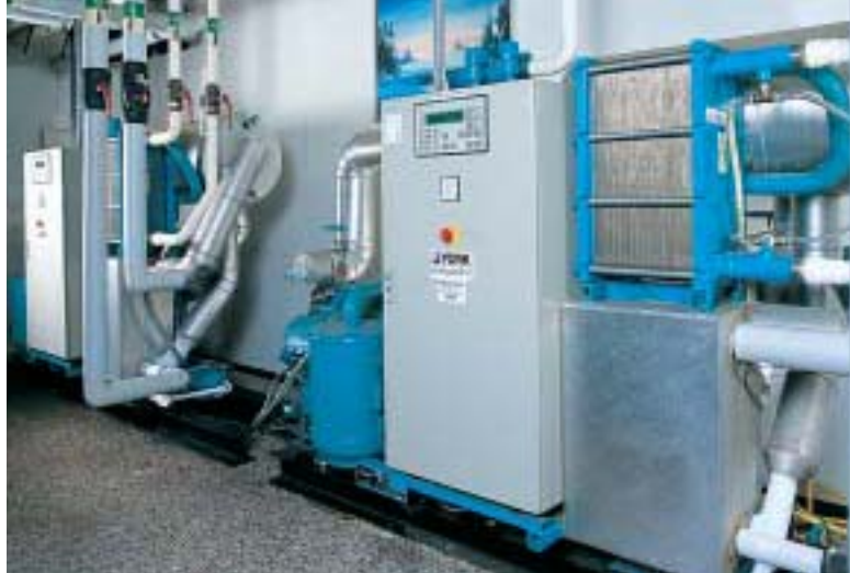
В машинном зале охлаждающей системы установлено два холодильных агрегата York Sabroe (хладагент – аммиак) с двойными компрессорами. В состав каждого агрегата входит никелевопаяный пластинчатый теплообменник Альфа Лаваль NB76-FS.
