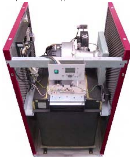
Фронтальный вид котла без обшивки
