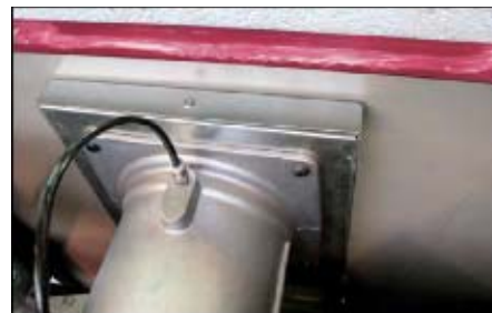
Фильтр, установленный в котел (вид сверху)
