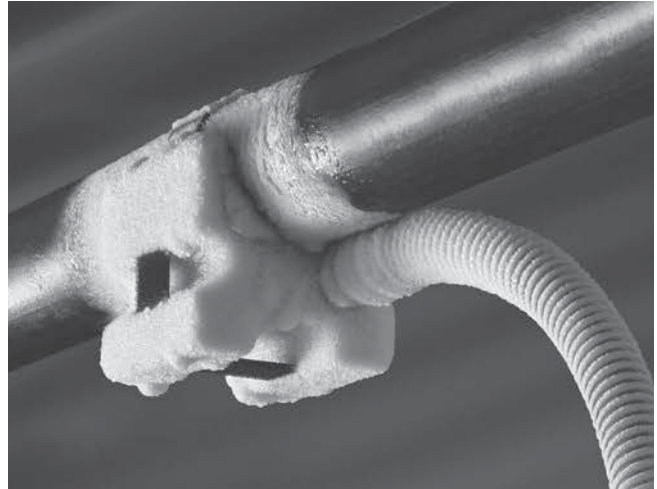
Slika 9 – Glava za zamrzavanje zamrznuta za cijev
