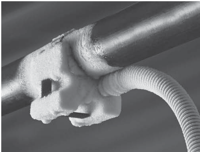
Figura 9 – Testa di congelamento congelata sul tubo
