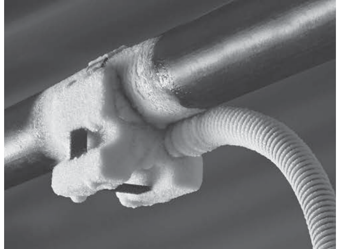
Kuva 9 – Putken jäädytetty jäädytyspää
