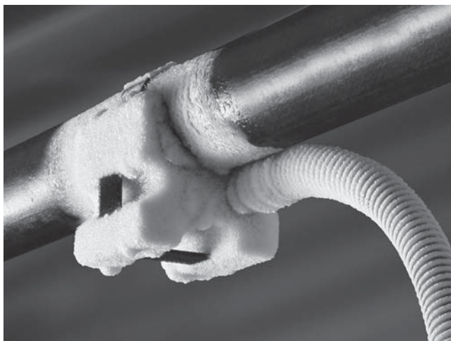
Figura 9 – Cabezal congelado contra la cañería
