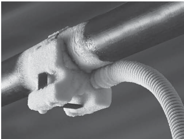
9-сурет – Мұздату басы құбырға қатырылған
