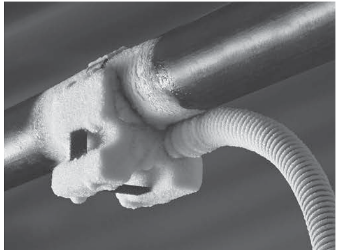
Figur 9 – Frysehode frosset til rør
