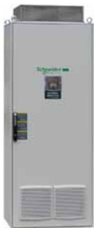
Комплектный преобразователь Altivar 61 Plus в шкафах исполнения IP 23 или IP 54 с фильтрацией гармоник
