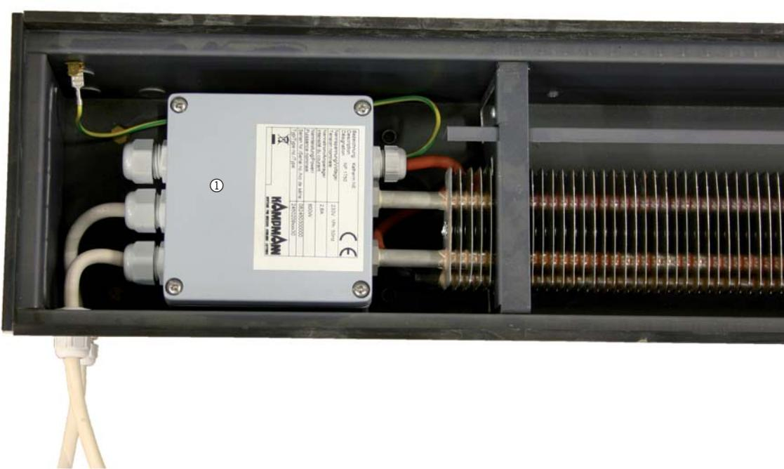
Рис.: ① Регулятор мощности
