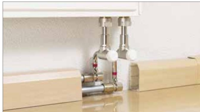
Рис. 16-47 Комплект левосторонних концевых присоединительных трубок SL-RAUTITAN 16 - 12
