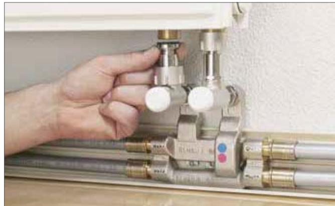
Рис. 16-26 Подключение угловых телескопических резьбозажимных соединений
