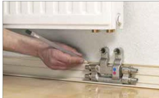
Рис. 16-32 Определение длины трубы
