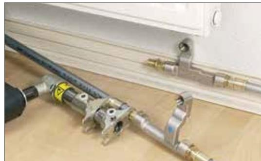
Рис. 16-34 Соединение с помощью надвижной гильзы, трубы диаметром 16 мм с крестовиной SL RAUTITAN из комплекта
