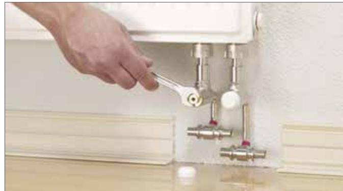
Рис. 16-45 Затяжка резьбозажимного соединения
