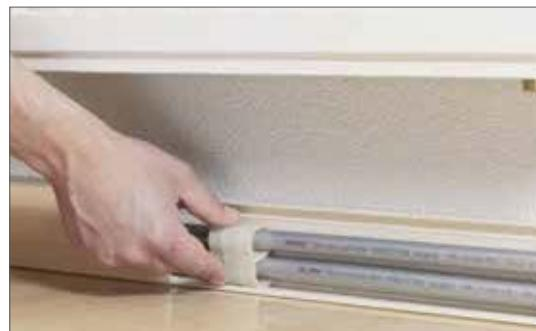
Рис.16-36 Установка фиксаторов труб отопительной разводки
