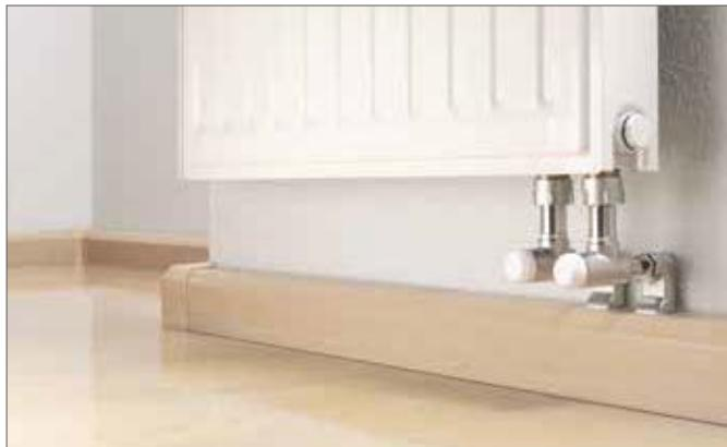
Рис. 16-16 Система плинтусных каналов RAUSOLO
