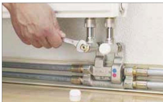
Рис. 16-38 Прочно затяните резьбозажимное соединение.
