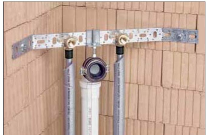
Рис. 5-3 Пример монтажа кронштейна
