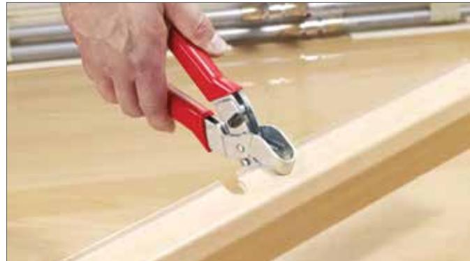
Рис. 16-46 Вырезка полуокруглых отверстий в крышке плинтусного канала
