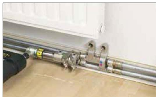
Рис. 16-33 Соединение с помощью надвижной гильзы, трубы диаметром 16 мм, с крестовиной из комплекта SL- RAUTITAN 16 - 12 - 16
