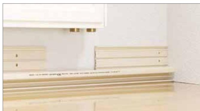
Рис. 16-43 Установленное основание плинтусного канала RAUDUO с выемкой
