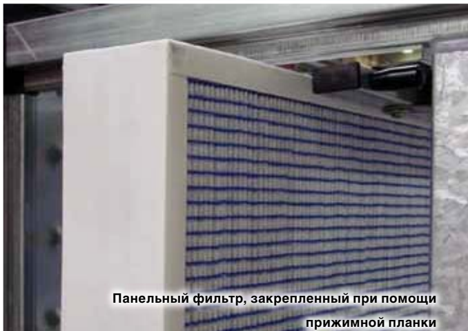
Стандартная рама для крепления компактных фильтров
