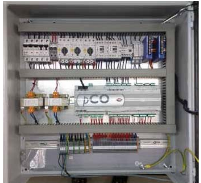
Примерное изображение аппаратуры управления «Airtronic Basic»
