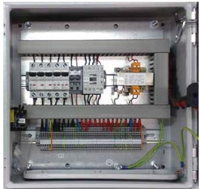
Примерное изображение аппаратуры управления «MSD-TR»
