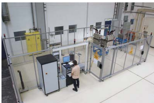
Испытательный стенд для проведения испытаний по проверке электрической прочности изоляции главных и вспомогательных цепей
