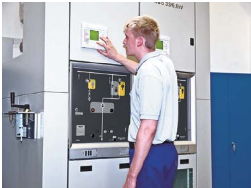
Распределительное устройство с одинарной системой сборных шин
