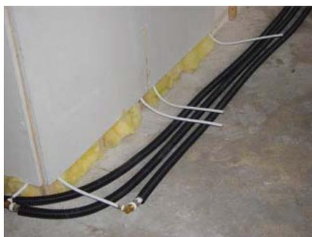
Подключение стеновых отопительных панелей
