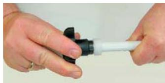
Подобрать калибратор, соответствующий диаметру трубы, вставить в трубу до упора. Проворачивая калибратор по часовой стрелке, снять фаску с внутренней кромки трубы. Проверить конец трубы на отсутствие заусениц. Для облегчения процедуры рекомендуется конец трубы или калибратор смазать силиконовым маслом или смочить водой. При использовании для привода калибратора шурупверта, максимальная скорость вращения ограничена 10 об/мин.
