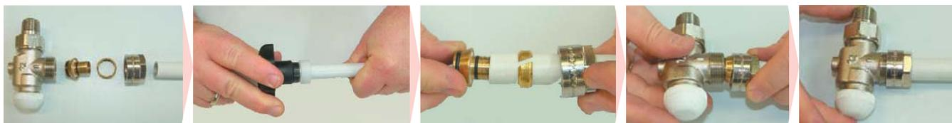
После этого с помощью соответствующего инструмента нужно дотянуть накидную гайку резьбового соединения на требуемый угол поворота в зависимости от типа фитинга.
