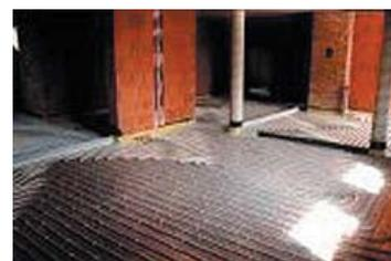
**Фиксирующие шины**, изготовлены из пластикового профиля с U-образными фиксаторами для крепления труб диаметром 16 x 2 и 17 x 2 систем напольного или стенового отопления. Крепление к теплоизоляции осуществляется двухсторонним скотчем или якорными клипсами. Позволяет закреплять трубу с шагом кратным 50 мм, а также имеет места разлома каждые 100 мм для формирования необходимой длины. В случае необходимости требуемую длину можно отрезать пилой.
