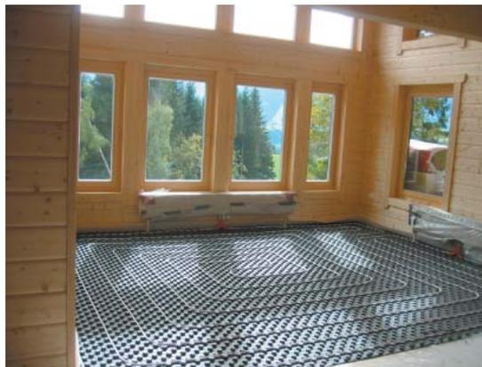
Шаг укладки труб на плитках составляет 50 мм. Размер плит – 1400 x 800 мм. Маты монтируются внахлест один на другой на 50 мм, полезная площадь составляет 1,12 м<sup>2</sup>.
