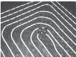
Маты с бобышками ГЕРЦ применяется при монтаже систем напольного отопления для укладки труб диаметром от 14 до 17 мм. Труба укладывается между бобышками путем вдавливания без дополнительного крепления. Маты без теплоизоляции можно применять при монтаже стеновых систем отопления. Они удобны в работе, обеспечивают надежное крепление труб.
