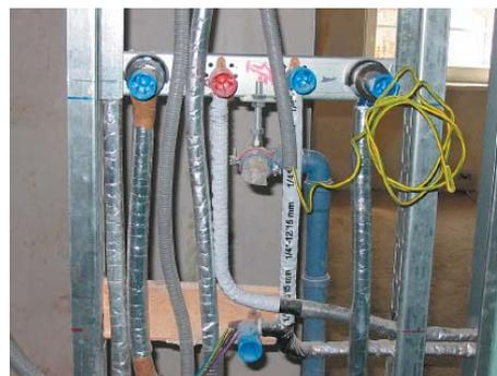
Пример: монтаж в стеновых перегородках
