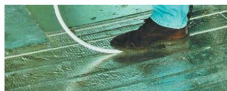
Плита покрыта алюминиевой фольгой, которая обеспечивает равномерную и эффективную теплоотдачу в помещении. Для организации поворотов, в том числе на 180° используются также «поворотные» маты с покрытием алюминиевой фольгой. Шаг укладки труб составляет 125 мм. Дополнительная обработка матов возможна с помощью ножа или прибора для горячей резки.
