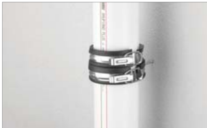
Рис. 7-3 Шумопоглощающий хомут в смонтированном состоянии
