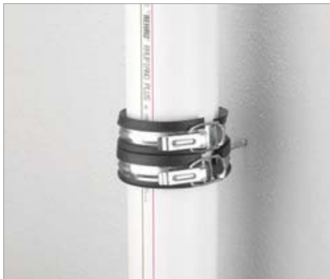
Рис. 2-5 Запатентованный шумопоглощающий хомут, состоящий из двух частей
