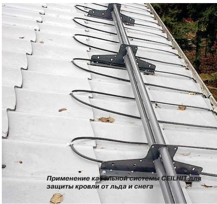
Применение кабельной системы CEILHIT для защиты кровли от льда и снега
