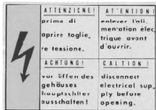
Табличка, предупреждающая об опасности поражения электрическим током - рядом с главным выключателем
