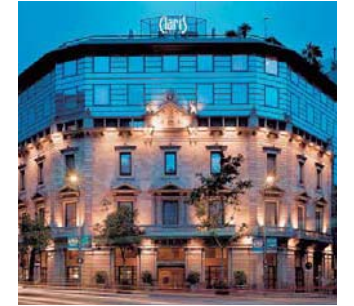
Переоборудование отеля Hotel Claris 5* Барселона, Испания ECOi
