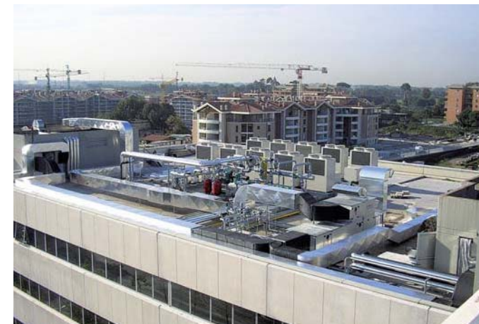
Замена чиллера. Подача холодной воды к фанкойлам.
