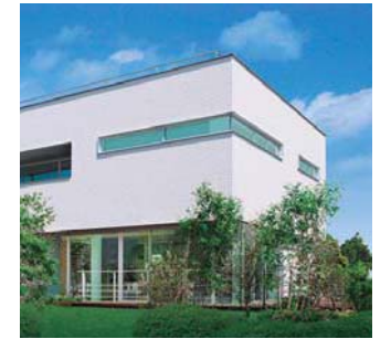
«Умный дом» Ариаке, Токио HVAC и комбинация генераторов солнечной энергии, батарей и аккумуляторов
