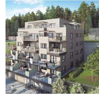
Новый кондоминиум Berges Terrasse Complex Драммен, Норвегия ECOi /Aquaarea
