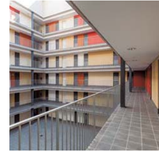
Новый 84-квартирный жилой дом Барселона, Испания Aquaarea
