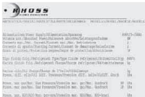
Заводская табличка расположена на боковой стороне агрегата. На ней указаны основные технические характеристики, а также серийный номер и модель агрегата.
