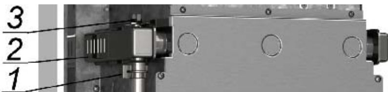
Рис. 17. Демонтаж теплообменника котла
