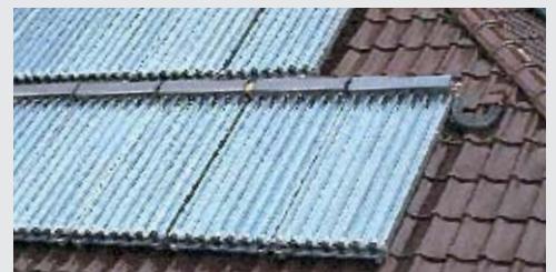
Установка на крыше
