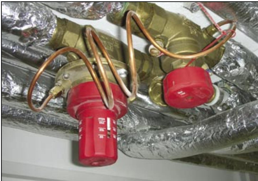
Рис. 14.2. Балансировочный вентиль Штрёммакс GR 4217 и автоматический регулятор перепада давления Герц 4007.
