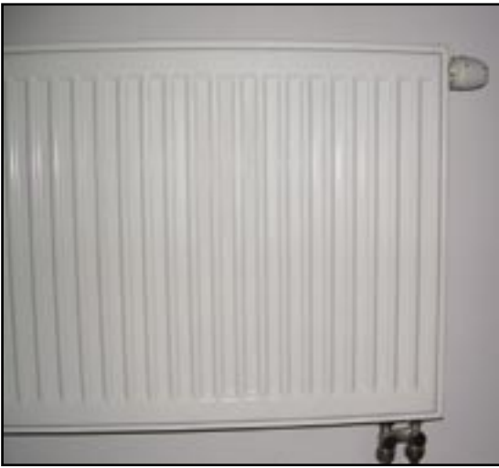
Рис. 11.9. Панельный радиатор с терморегулирующим узлом нижнего подключения Герц 3000
