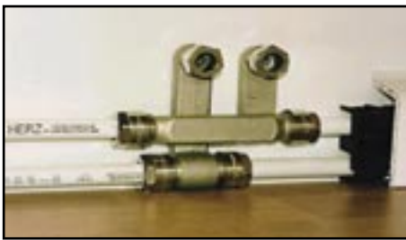
Рис. 10.4.а Вариант плинтусной разводки для двухтрубной системы отопления
