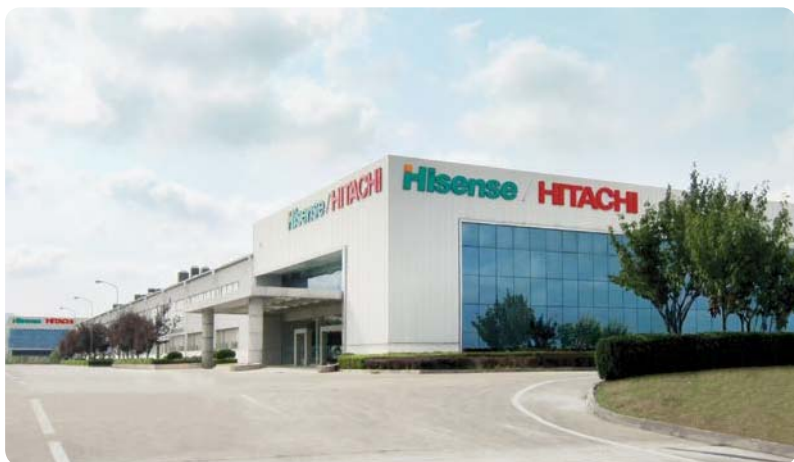
Завод Qingdao Hisense Hitachi Air-Conditioning system Co., Ltd., г. Циндао
