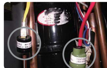
Выключатель низкого давления
