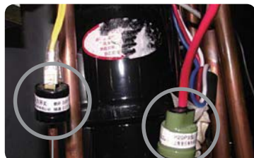
Выключатель низкого давления
