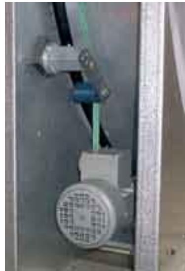
Электродвигатель роторного рекуператора
