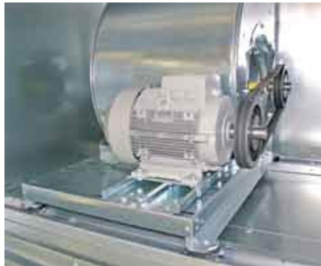
Вентилятор с ременным приводом
