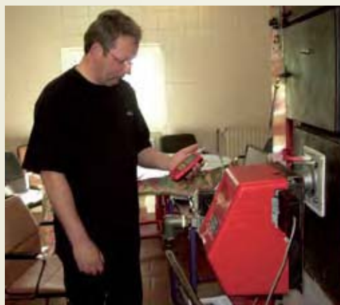
Рис.3 Монтаж и наладка параметров горелки
