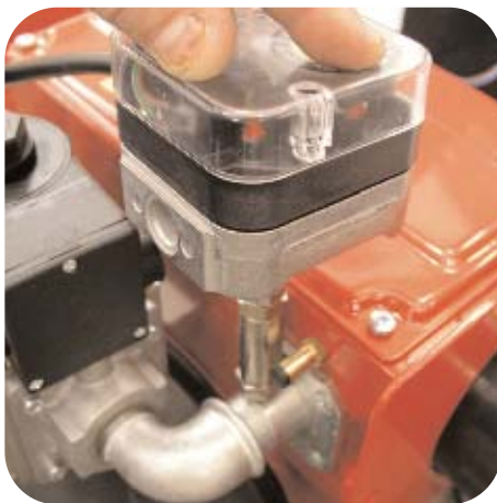
5-демонтировать штуцер отбора давления газа (Blu 170-250-350).
