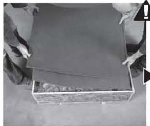
Gebruik het schuimrubber als bescherming op de vloer tijdens de montage van de Heatwave.
