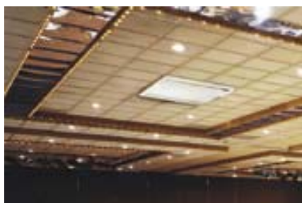
Установка на потолке
