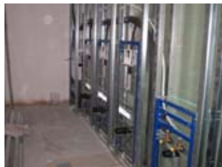
Монтаж умывальников в ряд «сухим» способом
