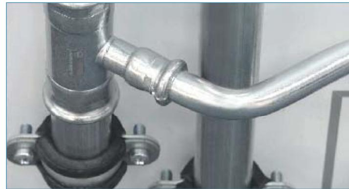
**Рис. 86** Подключение отопительного прибора (подающая и обратная подводка) в Системе **KAN-therm Steel**
