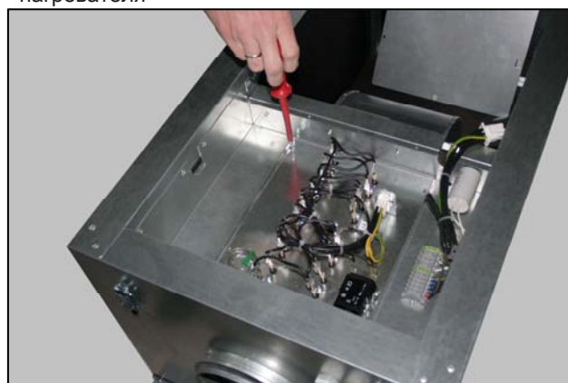
4. Зафиксируйте нагреватель с помощью саморезов
