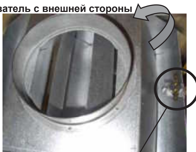
Термостат дымовых газов
