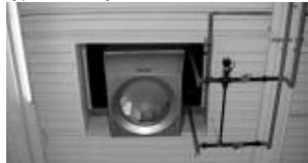
Рис.5. Агрегат TopVent® commercial с гидравлическим модулем
