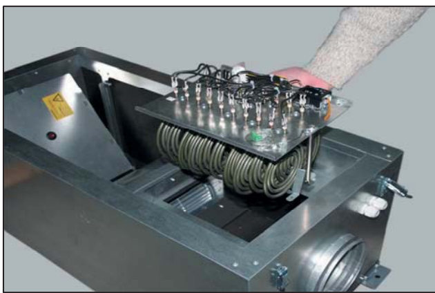
3. Установите нагреватель в отсек нагревателя
