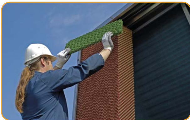
Монтаж водораспределительной панели
