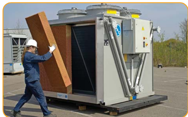
Установка предохлаждающего материала
