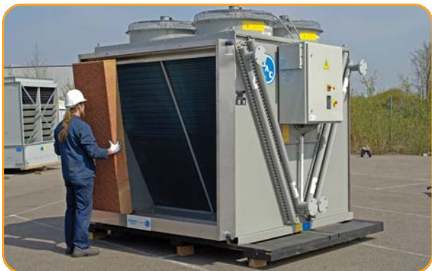
Установка предохлаждающего материала
