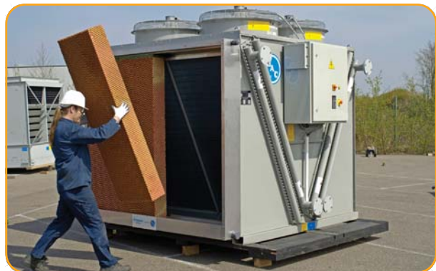
Установка предохлаждающего материала
