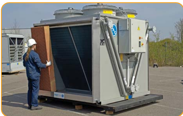
Установка предохлаждающего материала
