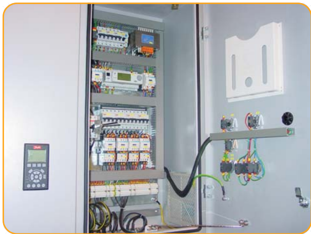
Панель управления с частотно-регулируемым приводом и интегрированным управлением адиабатическим процессом
