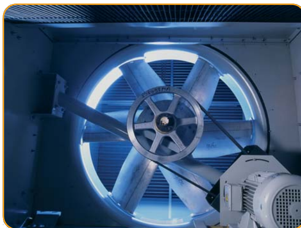
Система привода вентилятора
