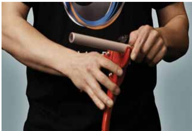
Резка трубы перпендикулярно к продольной оси трубопровода с помощью ножниц или трубореза
