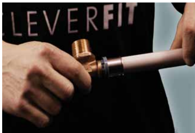
Визуальный осмотр. Проверьте соединение трубы с фитингом с помощью специального окошка.
