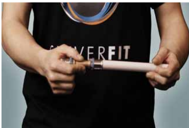
Установка трубы в муфту. Труба должна быть вставлена в муфту до упора.
