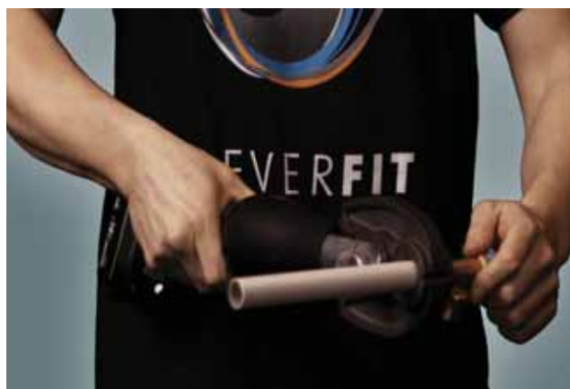
Выполнение соединения с помощью пресс-инструмента и обжимных насадок профиля ТН соответствующего диаметра.
