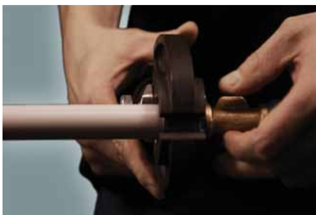
Вложите фитинг в обжимные насадки. Пластмассовые кольцо позволяет правильно установить фитинг в обжимные насадки профиля ТН.
