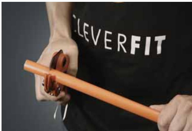
Отрежьте трубы перпендикулярно к продольной оси трубопровода с помощью ножниц или трубореза
