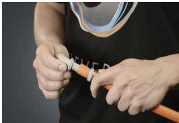
Вставьте фитинг до упора в расширенную трубу
