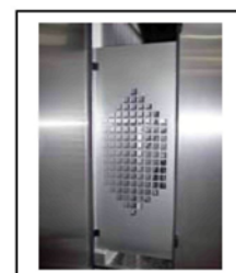
Защитный кожух вентилятора
