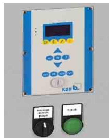
Монтаж в шкафу управления (СМ)
