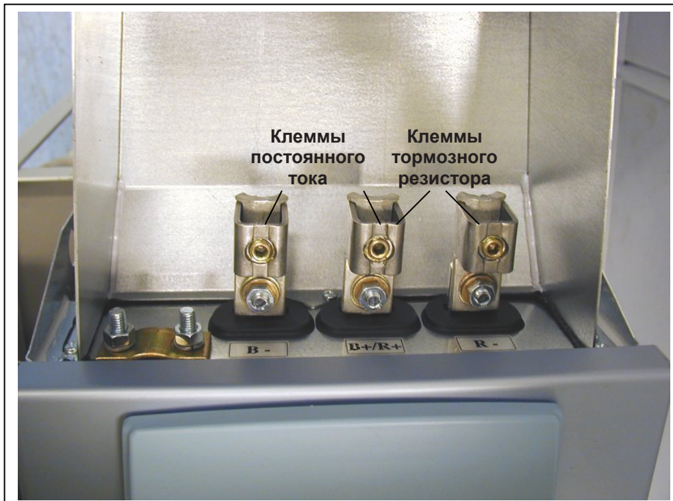
Рисунок 6-17. Клеммный модуль подключения тормозного резистора (сверху) FR8
